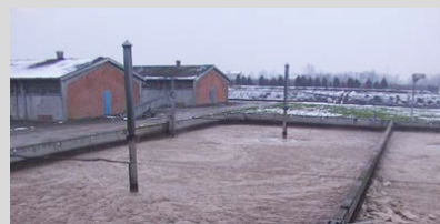
Impianto di depurazione SBR Azienda agricola S. Anna (MO)
